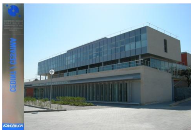
Edificio CeDInt- CeSViMa, Campus de Montegancedo (UPM)
